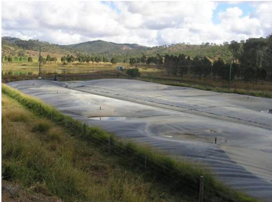
**FIGURE 2 - COVERED ANAEROBIC POND (CAP) IN AUSTRALIA**
